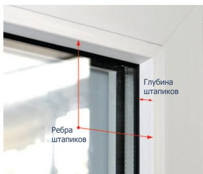
**ВНИМАНИЕ!** Замер производится с точностью до миллиметра.
